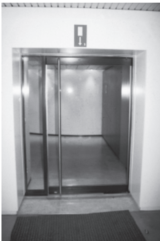
Afb. 12 Plaatsing van een deurdorpel bij een (glazen) Rf-deur.
